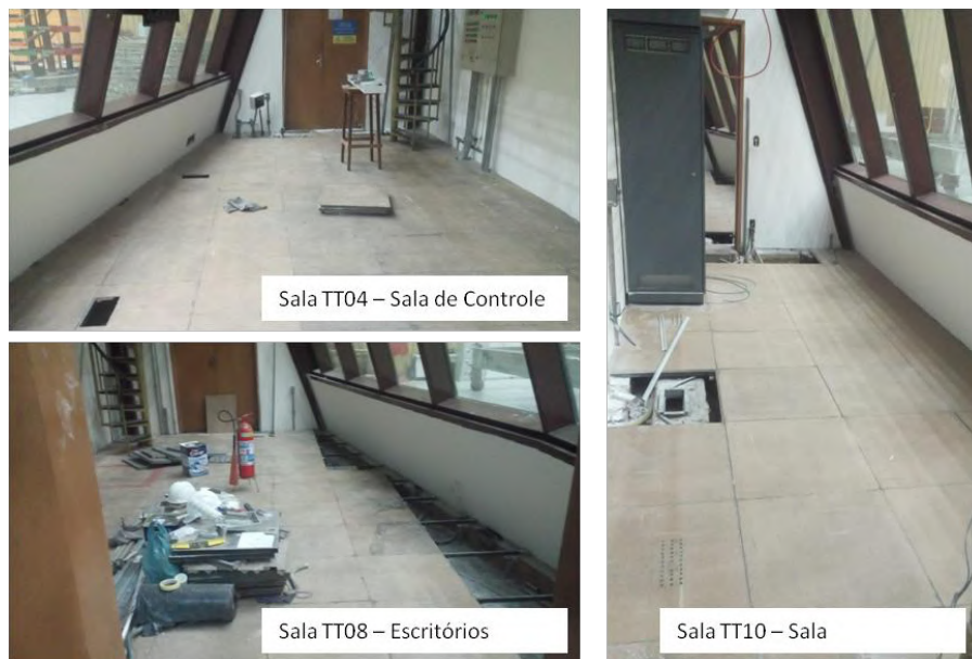
Figura 4: Imagem atual do Piso elevado existente que será substituído.
