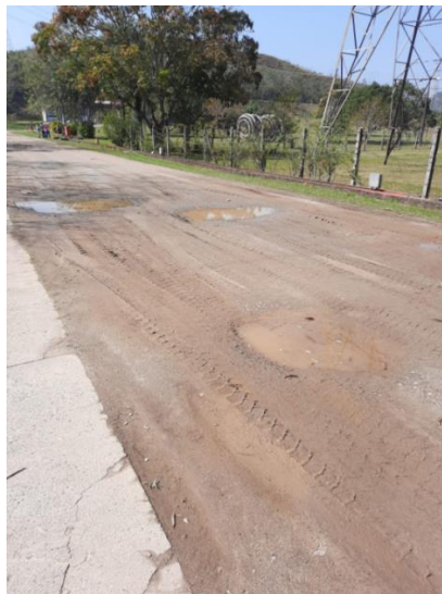
Figura 1: Estado atual do caminho que oferece acesso dos Blocos P ao U.
